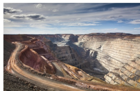
Las minas a cielo abierto a gran escala son obras maestras de la ingeniería medioambiental.
